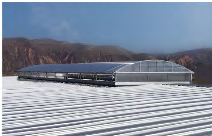
陇西仓储—圆拱型电动采光排烟天窗
