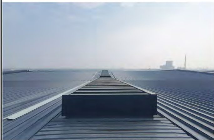
山西华恩-薄型通风器（顺坡启闭式）
