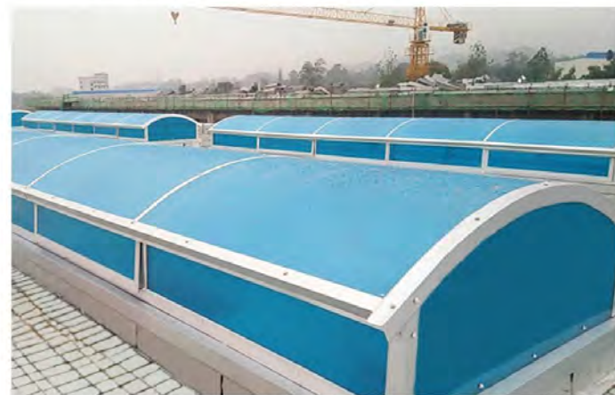
三元正极—圆拱型电动采光排烟天窗
