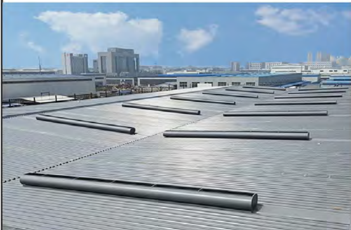
嘉润汽车-流线型通风器（顺坡开敞式）
