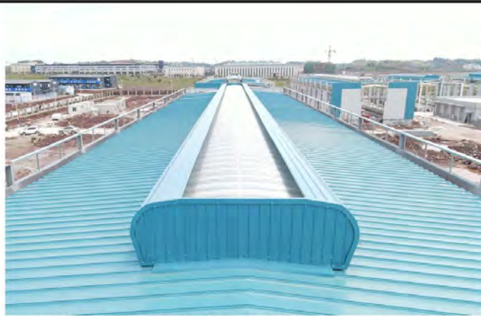
重庆同辉气弹-流线型通风器（屋脊开敞式）
